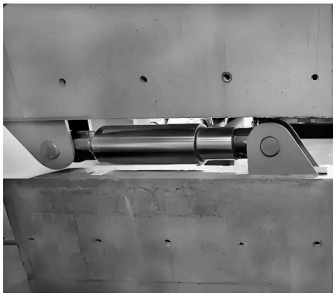
图 0.1 黏滞性阻尼器设备安装
